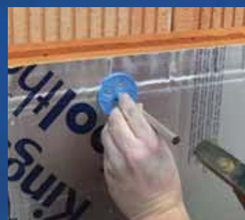
aanbrengen UNI-Perfoplug en inslaan m.b.v. Inslaghulp
