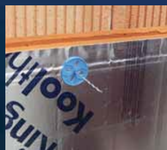
indraaien UNI-Bouwsouwanker m.b.v. Indraaihulpstuk
