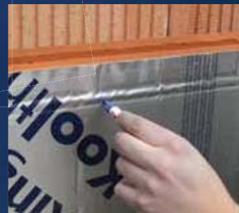
plaatsen isolatie en bepalen plaats UNI-Perfoplug
